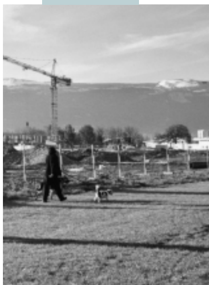
Vue du parc des Ruires et des bâtiments de la société Schneider en cours de construction. Dans la nouvelle zone des Ruires qui sera aménagée de l'autre côté de l'avenue d'Echirolles, le parc sera prolongé jusqu'à la colline.
